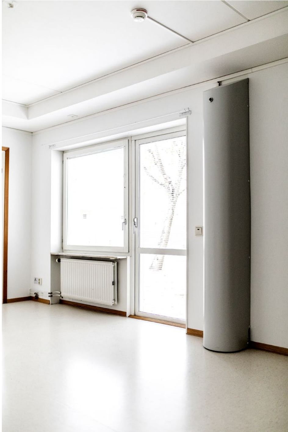
Detektoraktiverat släcksystem som kan installeras i en bostad. Foto: Pavel Koubek.
