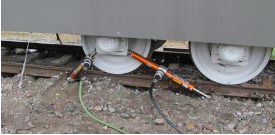
Figur 12. Exempel på användning av hydraul-stöttor för att säkra tågagn.
