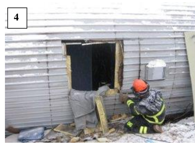
Figur 20. Hål i taket tas upp enligt "flerskiktprincipen" där man försiktigt arbetar sig igenom de olika materialen med lämpligt verktyg. Placera säkerhetsperson på insidan som markerar var tillträde skall skapas och markera exempelvis med borr var hålet kommer att bli. Hydraulverktyg är att föredra för avlägsnande av balk (bild 2). Här har man öppnat upp genom flera skikt (bild 3) och så småningom har man nått igenom (bild 3). Observera att öppningen bör göras tillräckligt bred för att underlätta evakuering från trångt inre utrymme. Beakta hatthyllan och eventuella andra strukturer som kan vara i vägen och skydda vassa kanter (bild 4).
