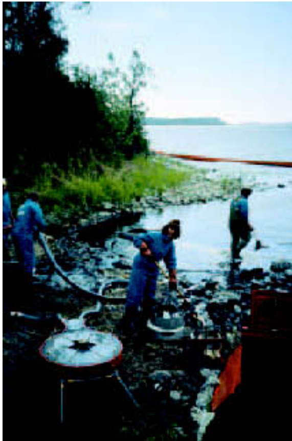
Salapump under användning i strandavsnitt. [Foto: Gustav Törling, SRV]
