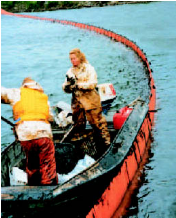
Utsläppet i Trollhättan 1988. Styrklänsa och oljeupptagning. [Foto: Gustav Törling, SRV]
