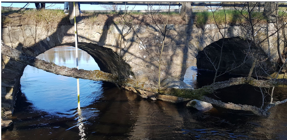
Figur 2. Manuell inmätning av äldre bro i samband med platsbesök den 2 maj 2023. Bron ligger i Ronnebyån uppströms dammen vid Dång. Ritningar saknas på bron.
