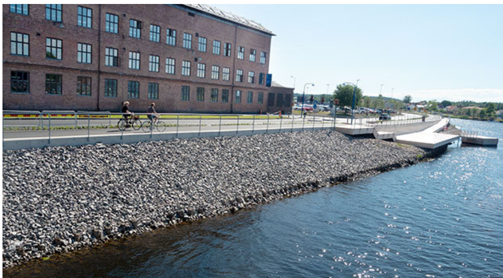
Figur 10: Del av översvämningsskydd, Centralsjukhuset Karlstad (Foto: Tjugofyra7).
